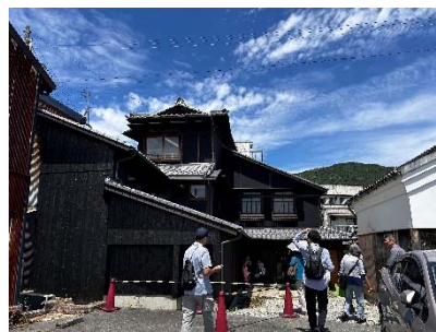
外壁等外側の工事が終わった旧秋武邸
