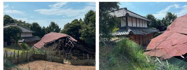
(県内：老朽化による空き家の自然倒壊)
