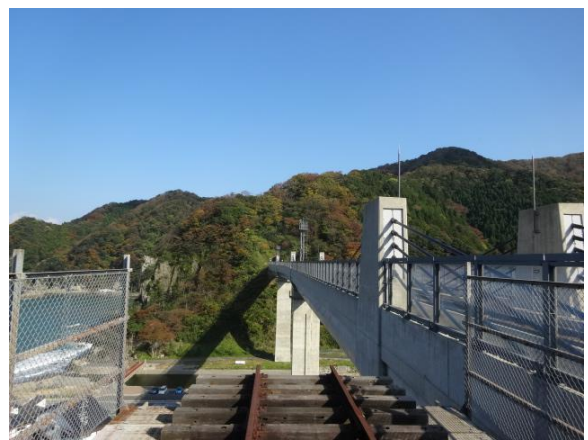
余部鉄橋「空の駅」
